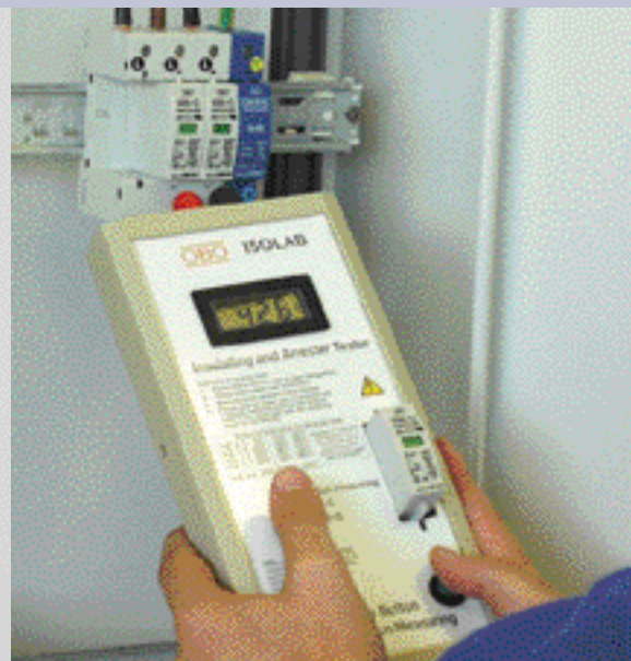
Измерение разрядников защиты от перенапряжения
