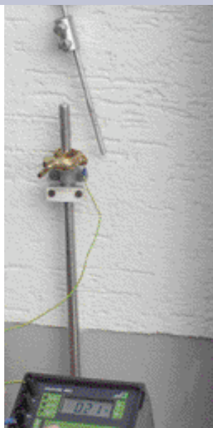
Измерение сопротивления заземления
