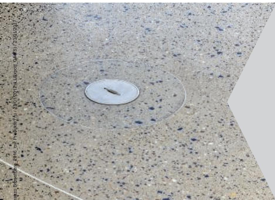
Кассетная рамка с опалубкой сконструирована таким образом, что она полностью оказывается - на поверхности пола, не образуя стыковых отверстий и швов. Выемка в крышке заполняется декоративным слоем цементного покрытия, который полируется отдельно, но тем же способом, что и остальной пол. Таким образом и достигается эффект отсутствия швов и зазоров. Точка доступа к сетям, проложенным в полу, оформляется таким же образом.
