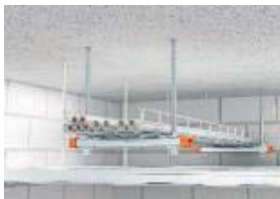
Одноуровневый потолочный монтаж над подвесным огнестойким потолком
