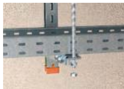
Монтаж стержней с резьбой при использовании соединительного угла на вершине кронштейна.
