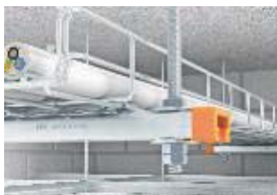
Крепёжный зажим для высокой нагрузки
