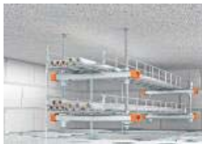
Двухуровневый потолочный монтаж над подвесным огнестойким потолком
