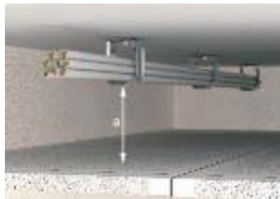
Необходимое минимальное расстояние до огнестойкого потолка
