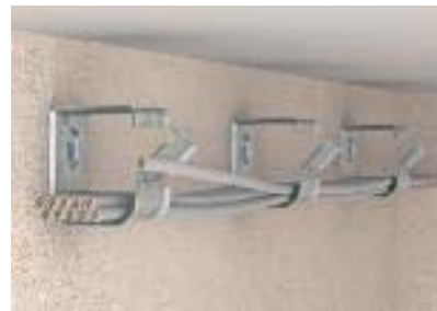
Простой ввод кабеля в открытое групповое крепление
