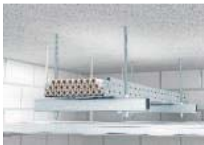
Одноуровневый потолочный монтаж над подвесным огнестойким потолком
