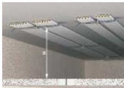
Необходимое минимальное расстояние до огнестойкого потолка
