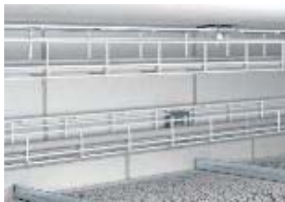
Прямой настенный и потолочный монтаж
