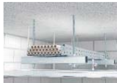
Необходимое минимальное расстояние до огнестойкого потолка
