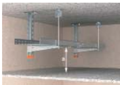
Необходимое минимальное расстояние до огнестойкого потолка
