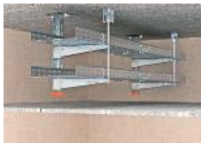
Двухуровневое крепление к потолку с односторонним расположением кронштейнов
