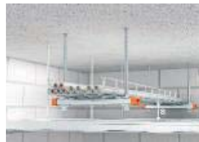
Необходимое минимальное расстояние до огнестойкого потолка
