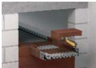
Монтаж разрезанных по размеру блоков
