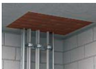
Тугая посадка при монтаже блоков в потолочном отверстии
