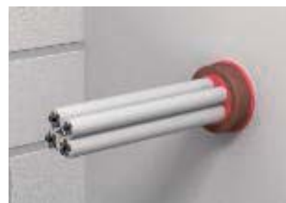
Монтаж при полной заполняемости огнестойкой оболочки
