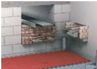
Отверстие заполняется подушками без шпатлевки или окраски
