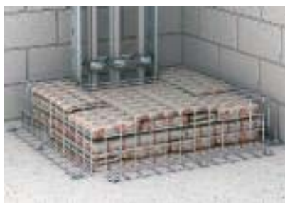
Фиксация от соскальзывания над полом
