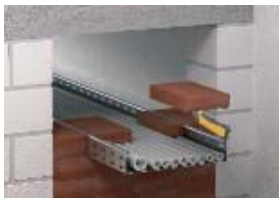
Монтаж разрезанных по размеру блоков
