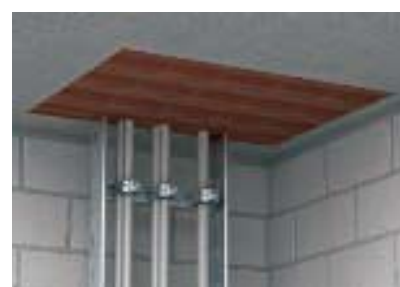
Прочная установка при монтаже блоков в потолочном отверстии
