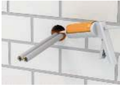
Заполнение отверстий шпатлевкой FBA-SP
