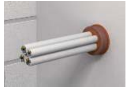
Монтаж при полном заполнении оболочки кабелем
