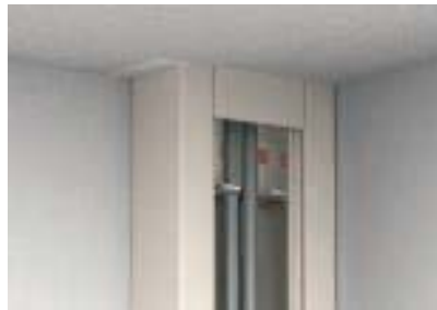
Крепежный уголок, предотвращающий соскальзывание при вертикальном расположении
