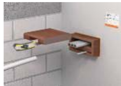
Обрезать по размеру внутренних деталей и фиксировать их в рамке
