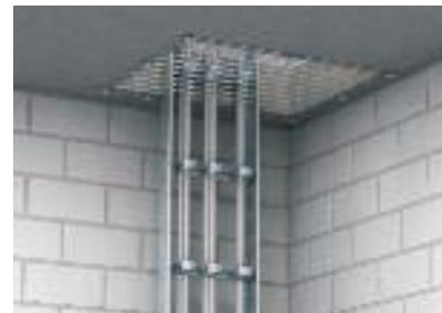
Фиксация от выпадения кабеля при потолочном монтаже
