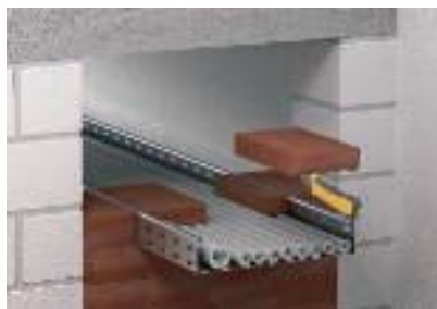
Монтаж разрезанных по размеру блоков
