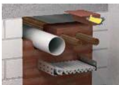
Ввод труб из воспламеняемого пластика без дополнительных мер по защите
