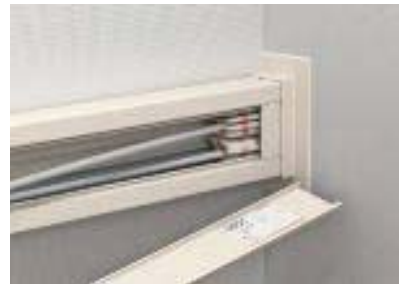
Незаметное размещение идентификационной таблички
