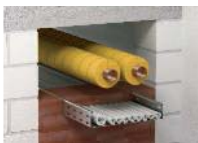
Установленные негорючие трубы с изоляцией участков
