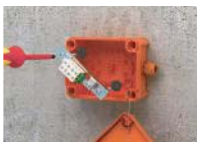
Монтаж с огнестойким винтовым анкером через скобу и основание FireBox
