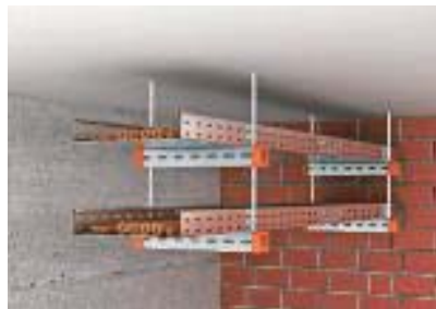
Двухуровневый монтаж к потолку
