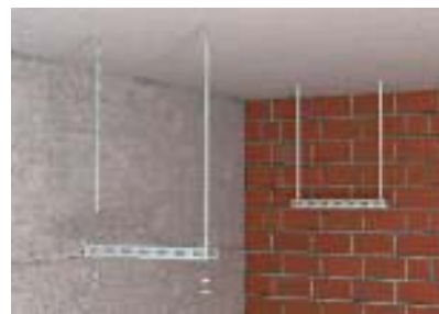
Монтаж резьбового стержня с шестигранными гайками и большими подкладными шайбами
