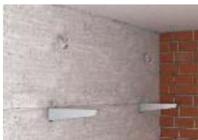
Настенный монтаж кронштейна и соединительных деталей
