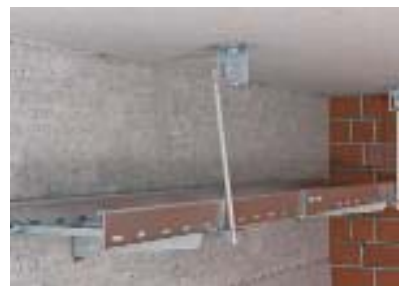
Потолочное крепление стержней с резьбой с огнестойким кронштейном
