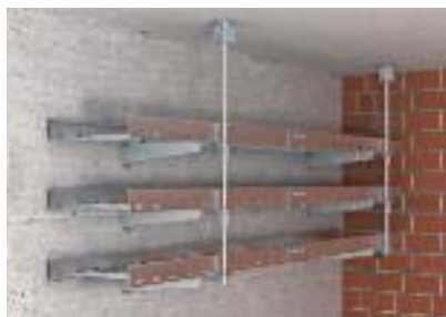
Настенный многоуровневый монтаж с фиксацией на стержнях с резьбой, вертикальный
