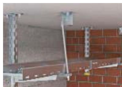
Крепление стержня с резьбой в огнестойкой скобе
