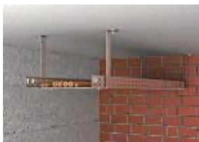
Одноуровневый потолочный монтаж с навесной скобой
