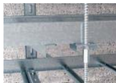
Монтаж резьбового стержня при многоуровневой прокладке трасс
