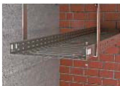
Крепление кабельного лотка винтами с полукруглой плоской головкой
