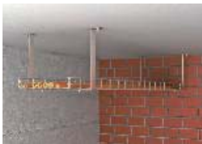
Одноуровневый потолочный монтаж с навесной скобой
