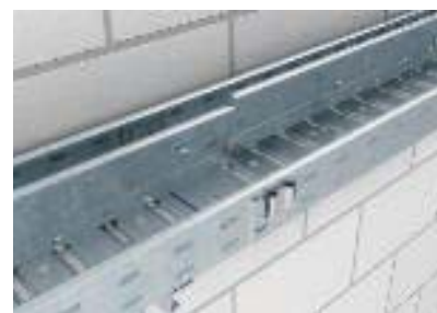
Монтаж разделительных полочек винтами с полукруглой головкой
