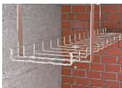
Крепление проволочного лотка зажимом и винтами с полукруглой низкой головкой
