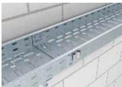
Вставленные стыковые соединения, загибать следует только накладку основания
